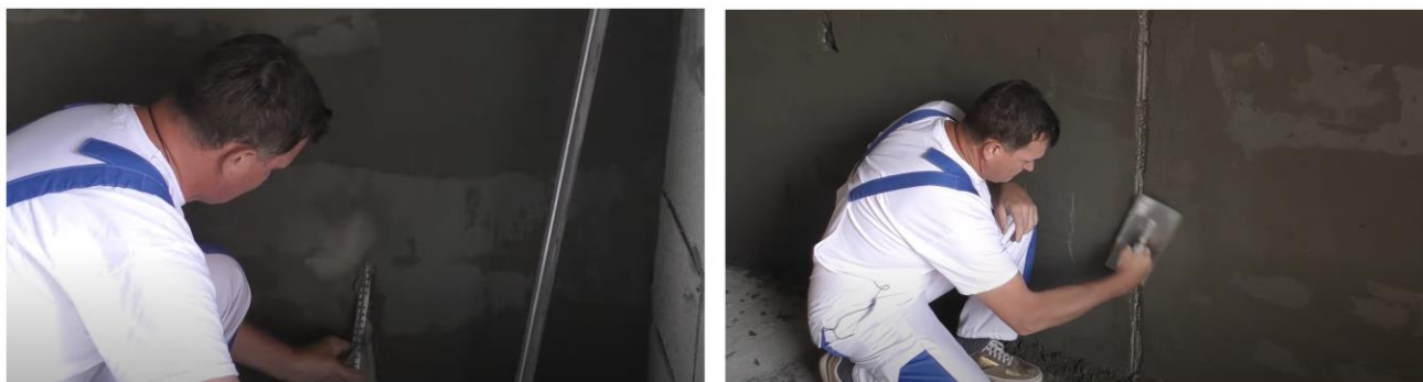
Рис. 20. Схема демонтажа маяков и заделки образовавшихся борозд
